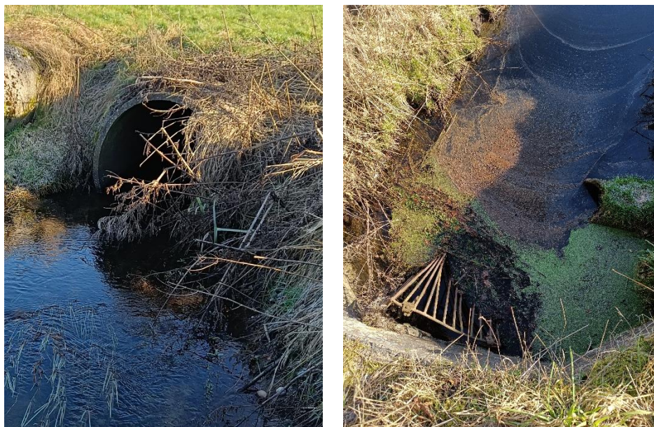
Figur 8: Rørets ind -og udløb v. Markdannersvej.
